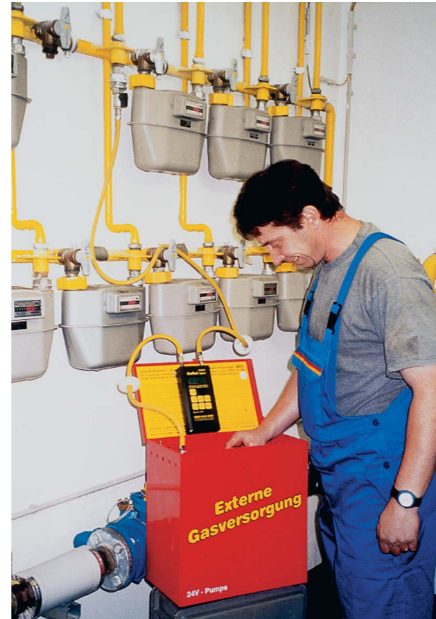
Abb. 8 · Gasspürgerät.
