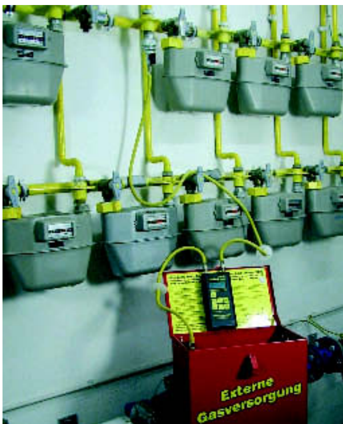
■ Leckmengenmessung mit Einspeiseanlage. Für Zeit sparende Messungen mit konstantem Betriebsdruck aus integrierter Gas-Vorratsblase mit Präzisionsdruckminderer durch Rückwärtseinspeisung bis zur geschlossenen Hauptabsperrreinrichtung.
