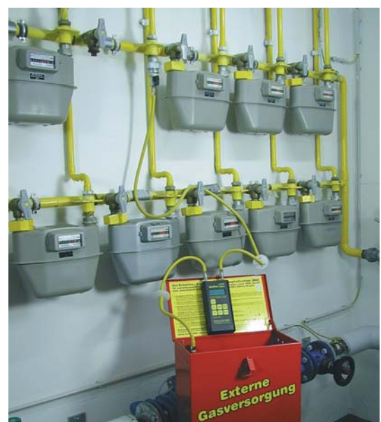
Anschlußschema mit Einspeise-Anlage
